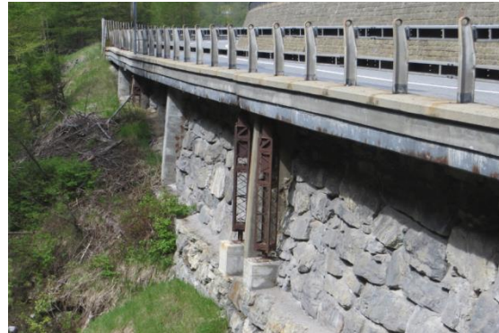
Pont en estacade près des ruines du château de Splügen
