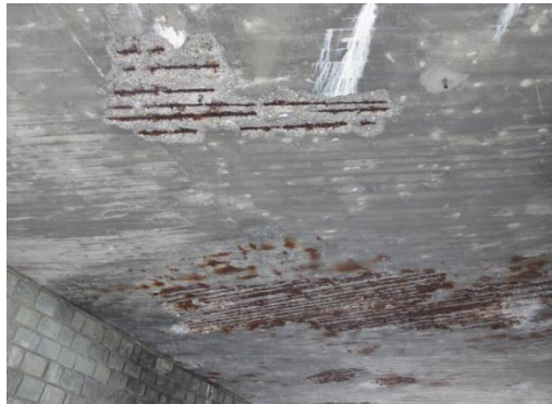
Passage souterrain de la route du col du Splügen
