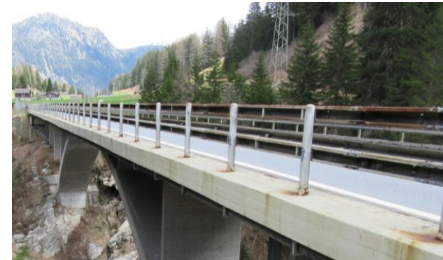
Pont « Grüne Brücke »
